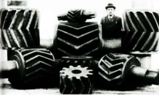
Kammwalzen im Stahlwerk Foto: Hoesch-Archiv, Dortmund
