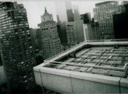
Dachbegrünung Apartmenthaus N.Y., Baustelle, Foto: Linda Pollak, NY Daidalos 63 · S. 112/113
