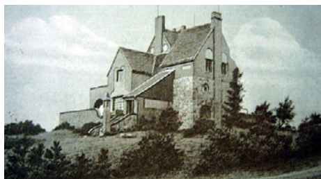
Blick auf die Süd-Ost-Fassade um 1910
