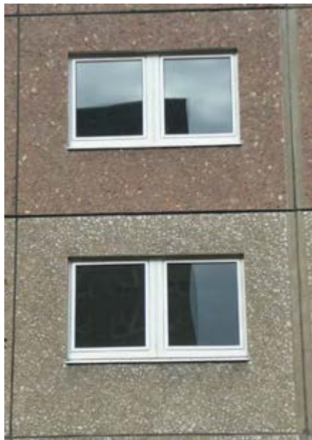
Haus 15: Bauzeit 1975-1978 [Ebd., S. 21], Foto: Klaus Rheidt dieser Bauwerke ist zwar im Sinne kunsthistorischer Denkmalebewertung weitestgehend unbedeutend, dafür aber historisch ‚kontaminiert‘, weist unsichtbare geschichtliche ‚Narben‘ auf, die mit ihrer heute nicht mehr vorhandenen Nutzung im Dienst des Staats-
